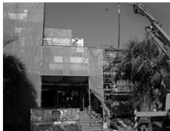
【工事中の玄関 平成15年2月17日現在】
