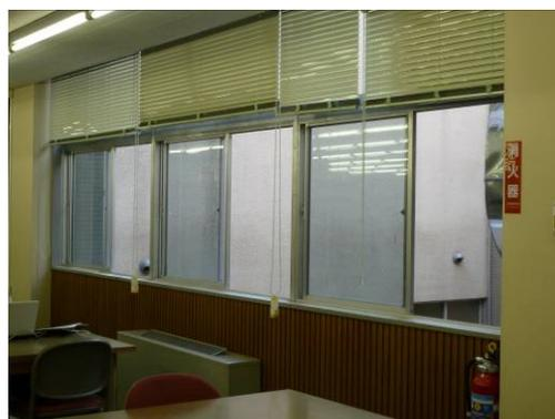
透明断熱タイプの UV カットフィルムを装備した窓ガラス (第 4 閲覧室)
